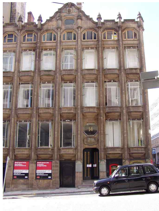
[그림 7: 오리엘 챔버스] 최초의 커튼월 구조를 적용한 빌딩 (영국 리버풀, 1864)
